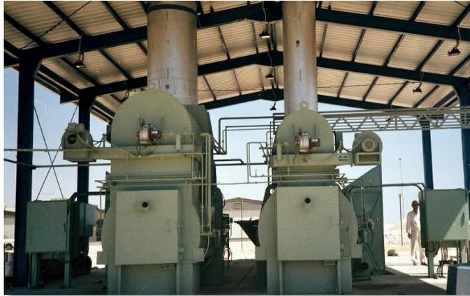
*Système de combustion d'extérieur à double réacteur de l'aéroport de Jeddah*
