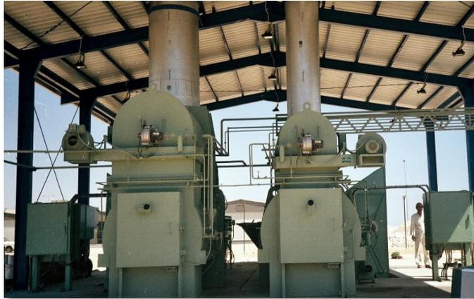
*Sistema de combustión de doble reactor al aire libre de la Entidad de Transporte de Yeda*
