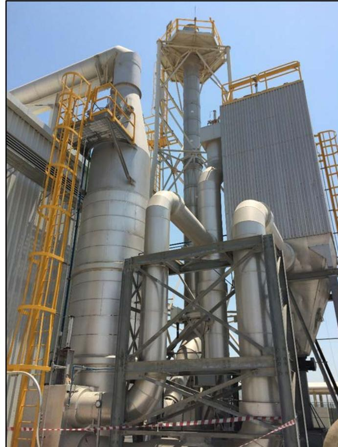
*Respirador evaporativo com depurador e chaminé para câmara de sacos de filtragem secos*
